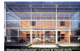
Matériau industriel - Lacton & Vassal Arch.
