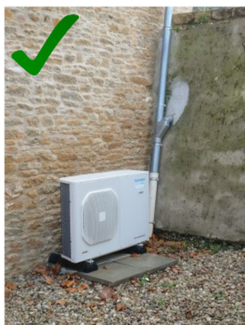
Climatisation cachée à l'abri des regards et mur faisant office de masque sonore
